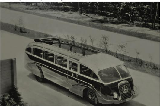
1935- Ônibus expresso, com teto solar, 95cv, 115km/h.
